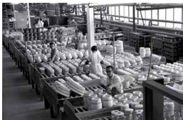
3_ east-riding - archives - Arquivo East Riding em unplash.com - linha de produção, enchimento de moldes com pasta líquida - Fábrica Hornsea Pottery (Inglaterra, anos 60)
